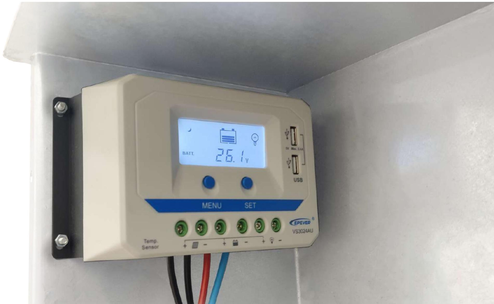
1.8. При правильном подключении соединительных кабелей солнечной электростанции с коробом АКБ, на табло контроллера отобразится символ «СОЛНЕЧНАЯ ПАНЕЛЬ»
